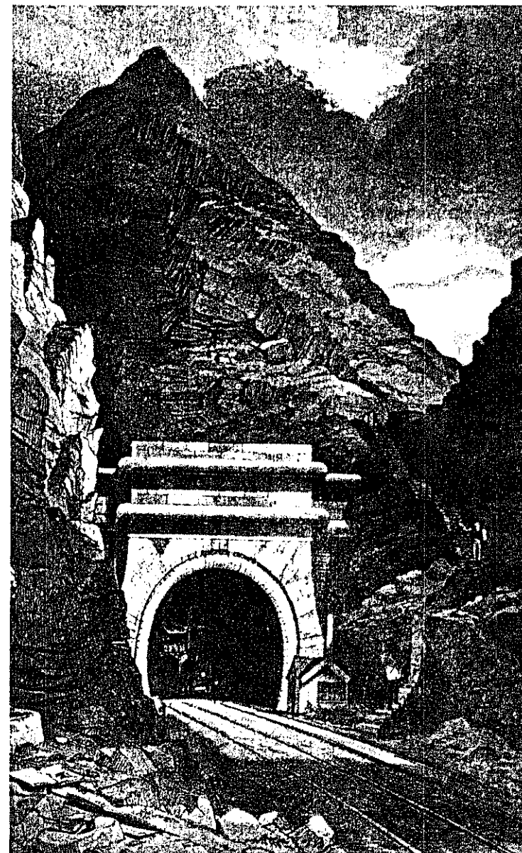
94. A. W. Tait, Túnel Summit, ferrocarril de Manchester a Leeds , 1845.
