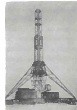
7 New self propelling telescopic dirigible mooring mast, U. S. N., Lakehurst, N. J.
