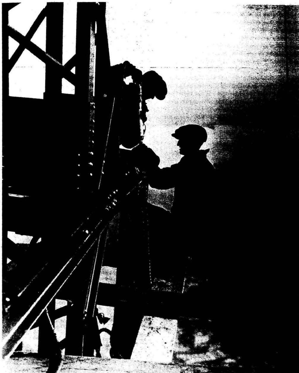
LEWIS WICKES HINE, Operarios del acero sobre el Empire State Building, Nueva York, 1931 . Gelatino-bromuro, George Eastman House, Rochester (Nueva York)
