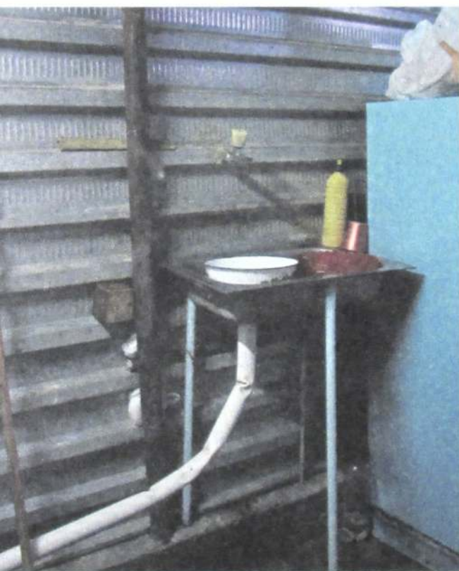
Tuyau d'évacuation d'eau.
